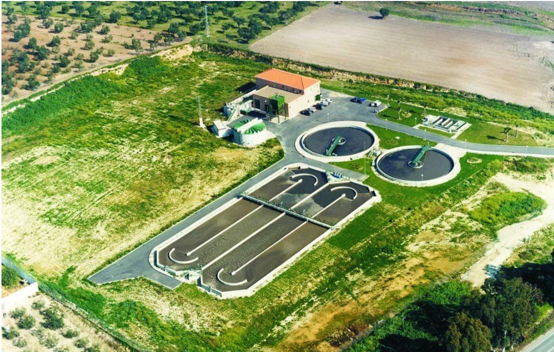
EDAR de Utrera. Fonte: Xunta de Andalucía
